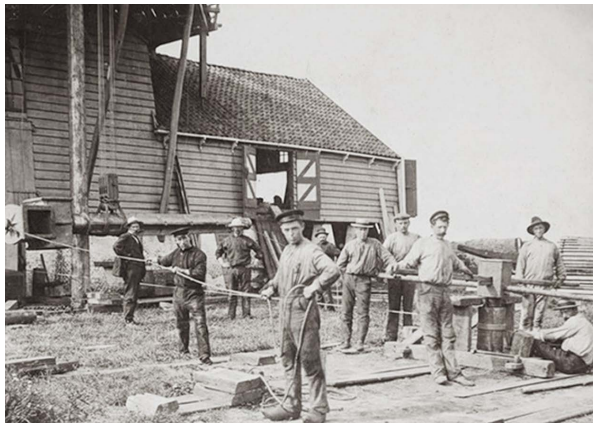
Het hijsen van de ijzeren as van gietij J.M. de Muinck Keizer; Martenshoek (Gr), rond 1900. De as weegt ongeveer 3.000-3.500 kg. (Foto's: archief Van Rееuwijk bouwmeester)
