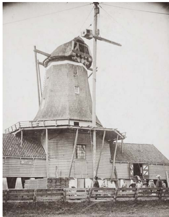
Het hijsen van de ijzeren as van gietij J.M. de Muinck Keizer; Martenshoek (Gr), rond 1900. De as weegt ongeveer 3.000-3.500 kg. (Foto's: archief Van Rееuwijk bouwmeester)
