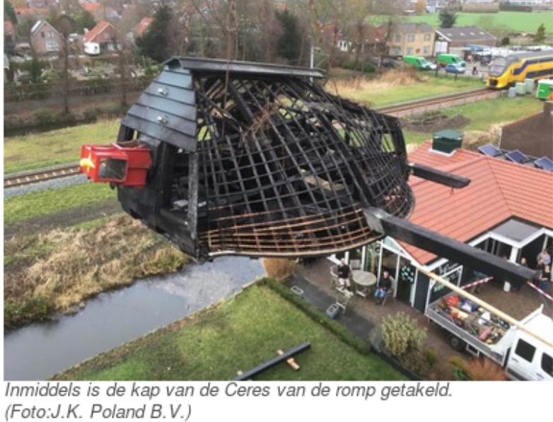
Inmiddels is de kap van de Ceres van de romp getakeld. (Foto: J.K. Poland B.V.)
