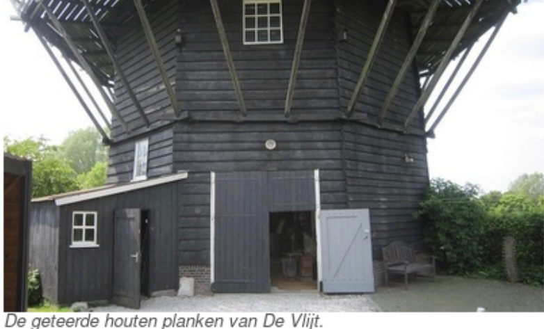
De geteerde houten planken van De Vlijt. (Foto: Stichting De Wijhese Molen)
