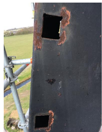
Foto's bij 25b+c – Voorbeelden van onregelmatige heklatgaten. Vanuit de hoeken kunnen gaten ontstaan.
