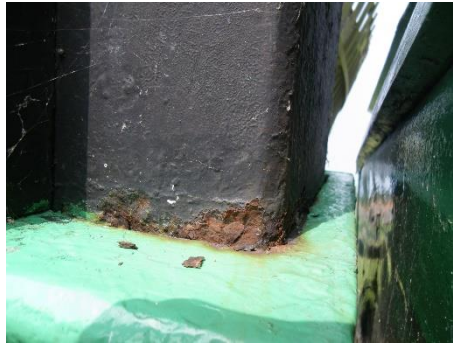
Foto bij 29 – Voorbeelden van ernstige roestvorming (putcorrosie) aan de roede langs de askop.
