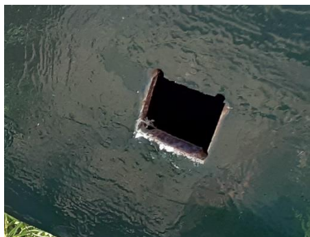
Foto's bij 25b+c – Voorbeelden van onregelmatige heklatgaten. Vanuit de hoeken kunnen gaten ontstaan.
