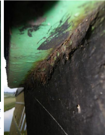
Foto bij 29 – Voorbeelden van ernstige roestvorming (putcorrosie) aan de roede langs de askop.
