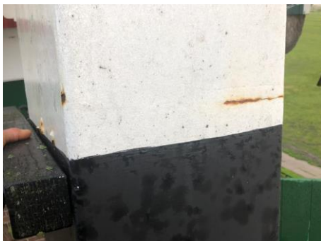
Foto bij 31a+b – Voorbeelden van lijnvormige roestvorming betekende in deze gevallen risicovolle scheurvorming
